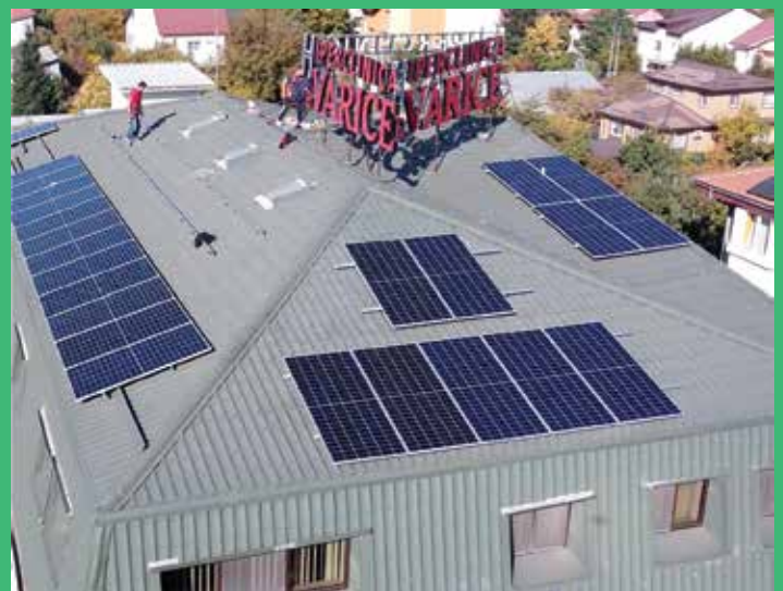
SISTEM FOTOVOLTAIC 22 KW
